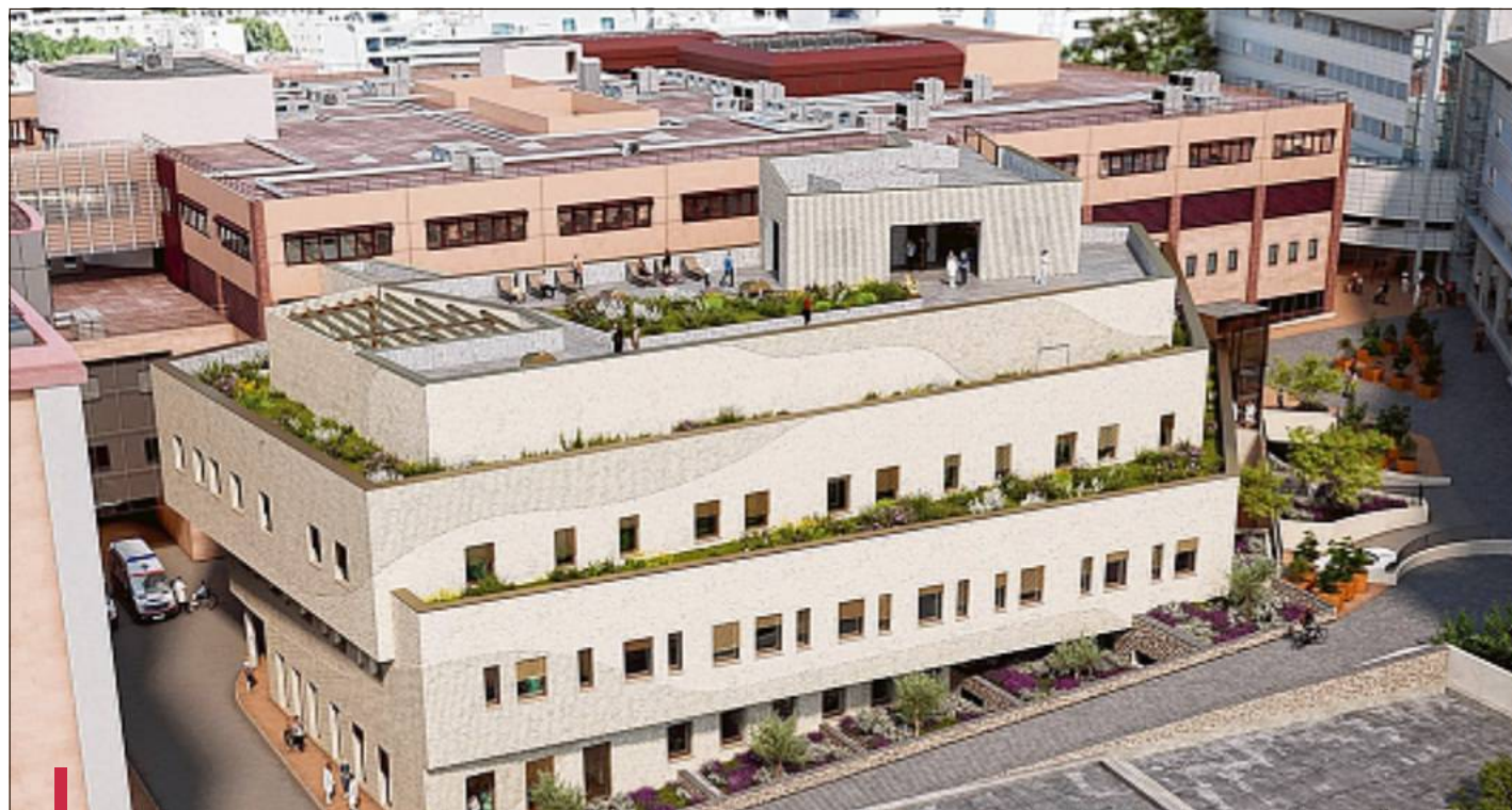
Ce bâtiment de trois étages, situé du côté du boulevard Latil accueillera des blocs opératoires, les explorations cardiaques, la pneumologie et l'ophtalmologie. Il sera livré fin 2024.
